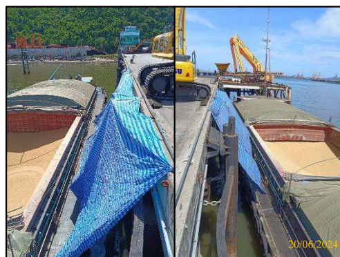
รูปที่ 2-14 ผ้าใบสำหรับป้องกันการร่วงหล่น ระหว่างเรือลำเลียงและท่าเรือ
