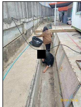
รูปที่ 2-74 เจ้าหน้าที่ทำความสะอาดและตรวจสอบรางระบายน้ำฝน
