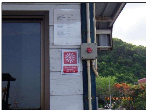
รูปที่ 2-59 อุปกรณ์แจ้งสัญญาณฉุกเฉิน
