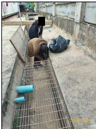
รูปที่ 2-74 เจ้าหน้าที่ทำความสะอาดและตรวจสอบรางระบายน้ำฝน
